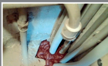
ELEKTRO- U. BRANDSCHUTZ
